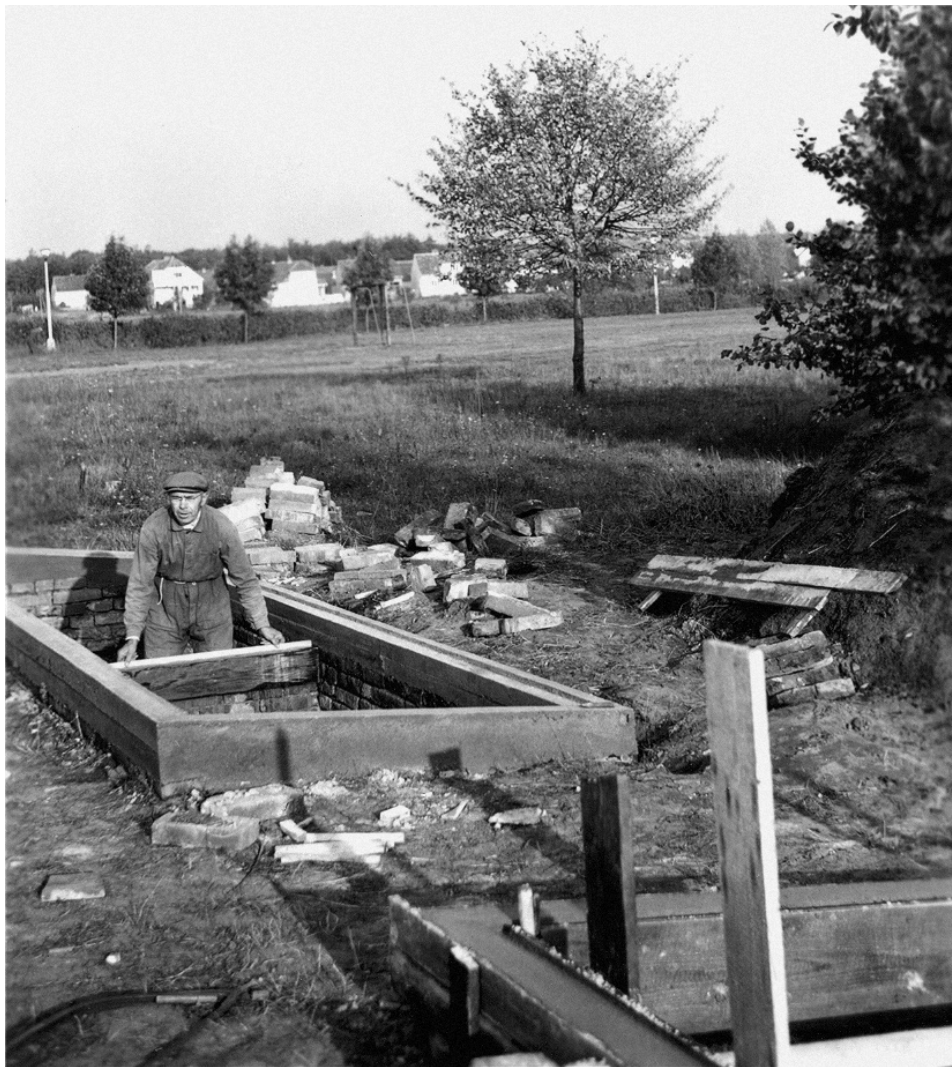
Rok 1969 - Dekář Antonín při opravě pařeniště u nové školy (bylo postaveno během prázdnin v r. 1970).
