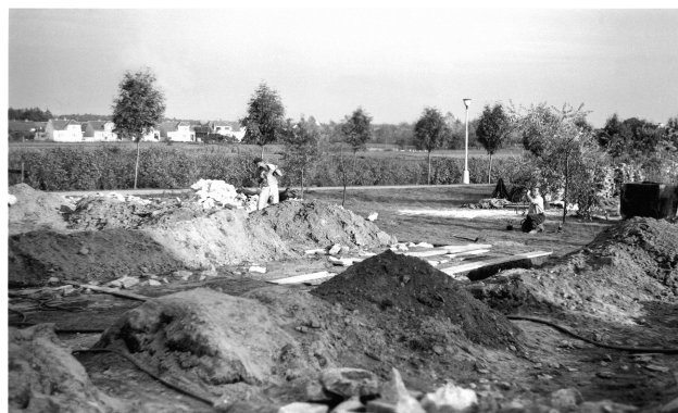
Staveniště tělocvičny, vzadu domy v ul. U Jezérka.
