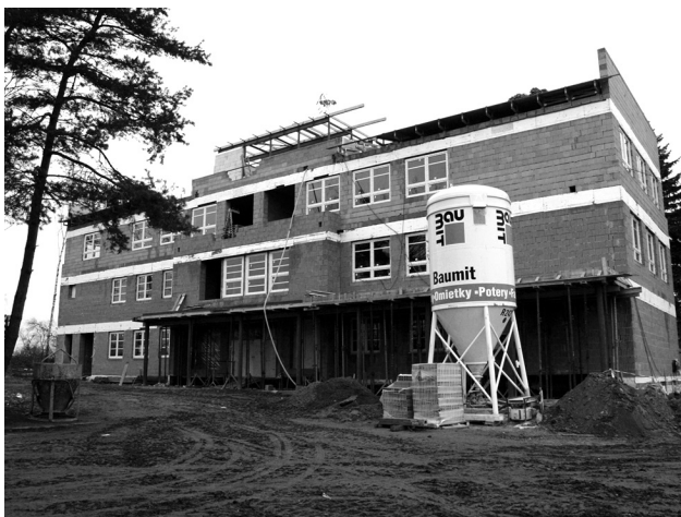
Staveniště přístavby 16. prosince 2006
