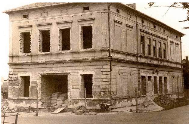
Přestavba budovy staré školy v ulici Ulička na školní jídelnu (květen 1974).
